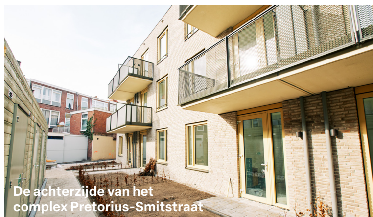
Het complex Pretorius-Smitstraat in aanbouw
