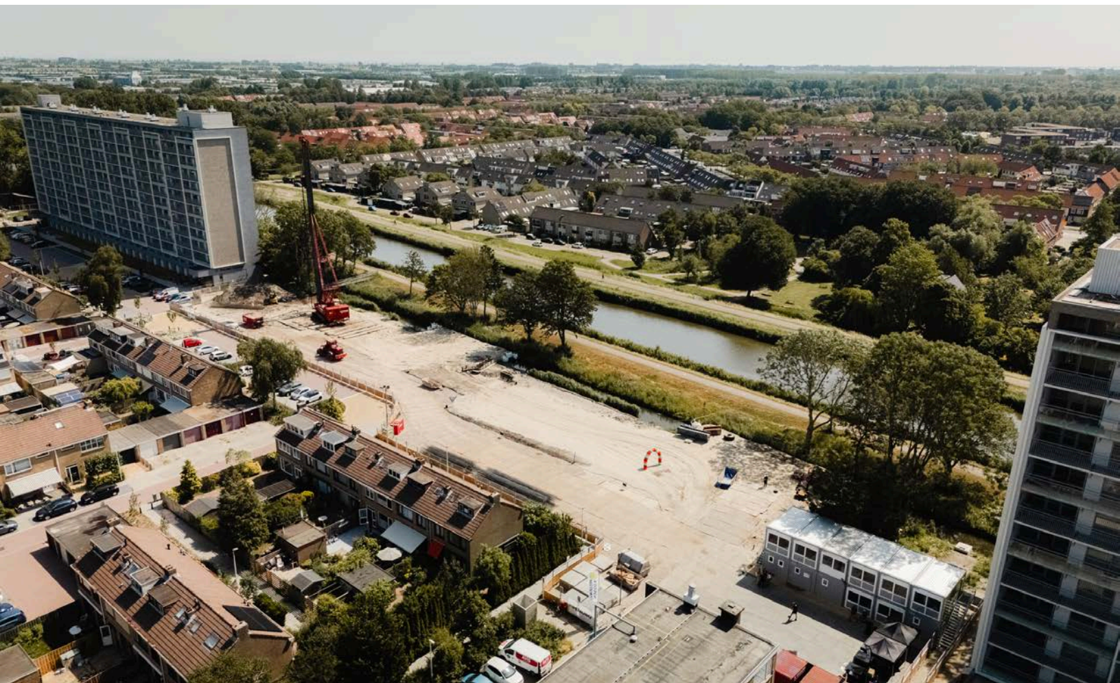
*Start van de bouw Gouwzeestraat Purmerend
