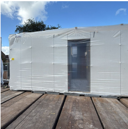
16. De prefab gevels komen aan in pakketten.
