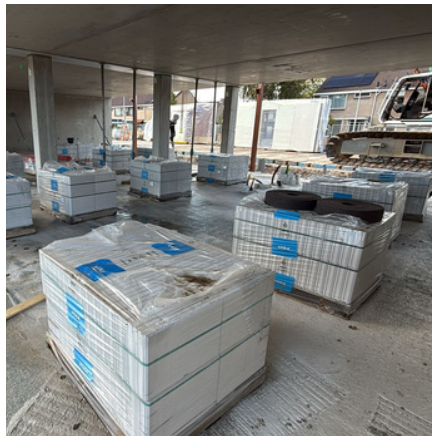
17. Ook de kalkzandsteen blokken (duurzaam kunstmatig bouw materiaal), voor dragende binnenmuren, fundering en spouwmuren worden in pakketten aangeleverd.
