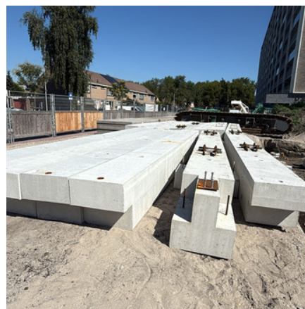
3. De eerste funderingsbalken zijn aangekomen.
