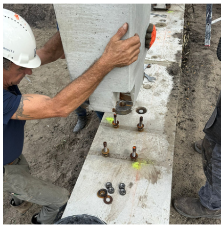
11. Onze vaklieden monteren de kolommen en vloeren. Alles is demontabel.
