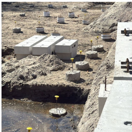
4. De fundering wordt aangebracht.
