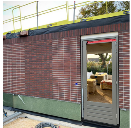
18. De gevel is gemonteerd.
