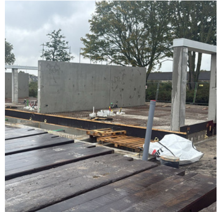
15. Op de begane grond worden de wanden geplaatst.
